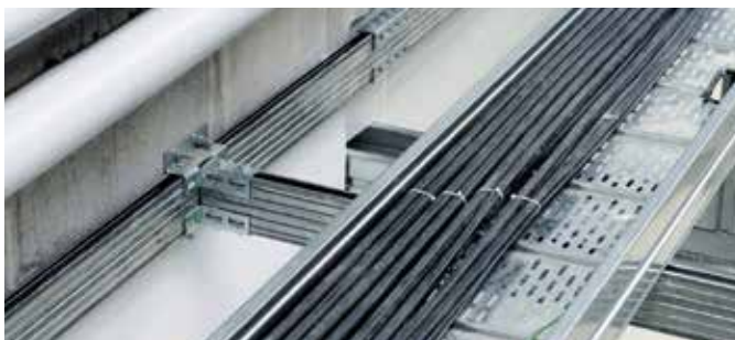
Verlegung von Kabeln.
