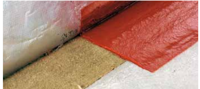
① Fuge Außenwand (Fassade) zum Boden.
