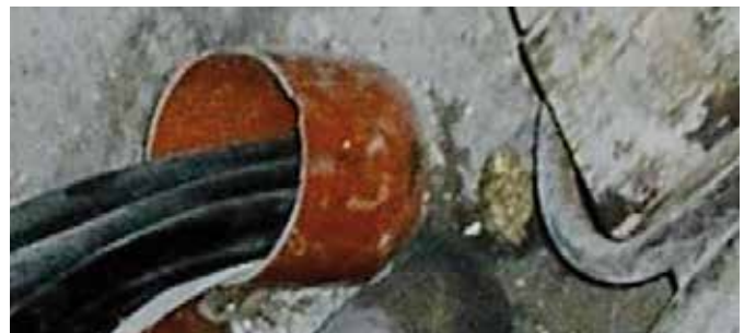
Hüllrohr bündig mit Wand/Decke abschneiden.
