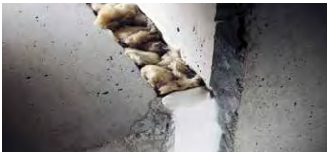
Elastische Brandschutzdichtmasse CFS-S SIL, Brandschutzfugenfüller CFS-S ACR.
