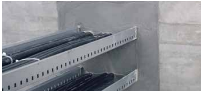
Abschottung sehr großer Durchführungen mit Brandschuttmörtel CP 636.
