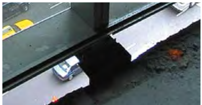
Offener Spalt zwischen Fassadenelement und Decke.
