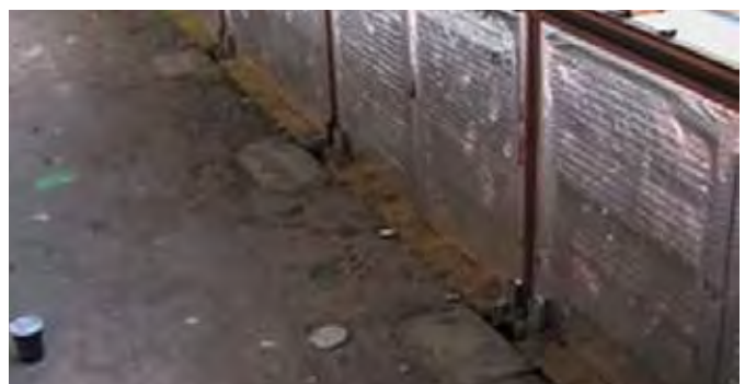
Mit Mineralwolle geschlossener Spalt.
