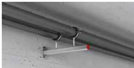
Nicht abgehängte Konsole
