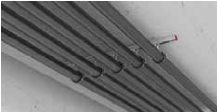
Schiene direkt an der Decke
