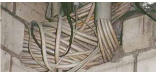
Abschottung mit mehr als 60 % Belegung ist nicht zulässig.
