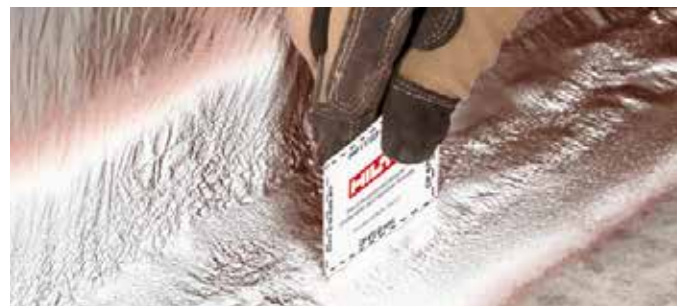
Überprüfung der Dicke des Nassfilms.
